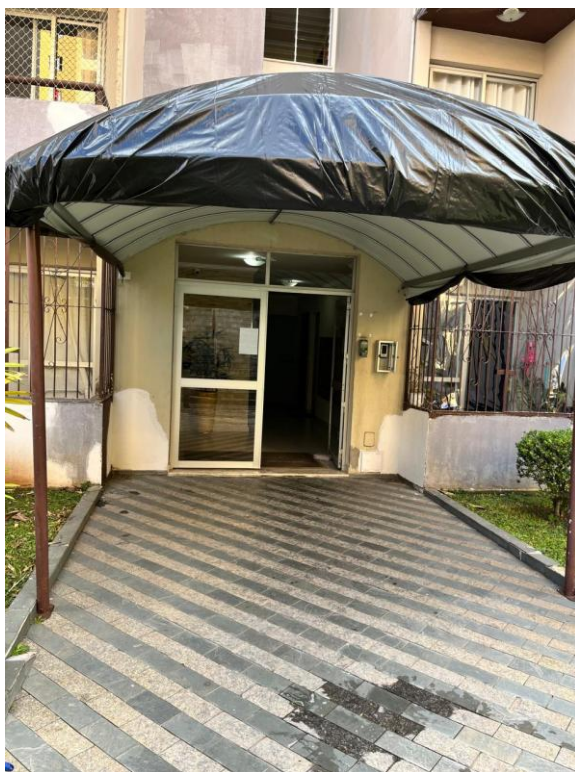
Entrada do Bloco 08
