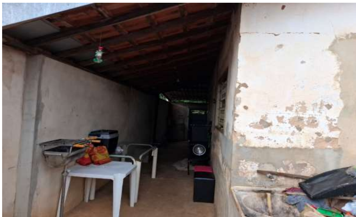
Foto Nº 09: Ainda aspectos externos da Casa Principal.
