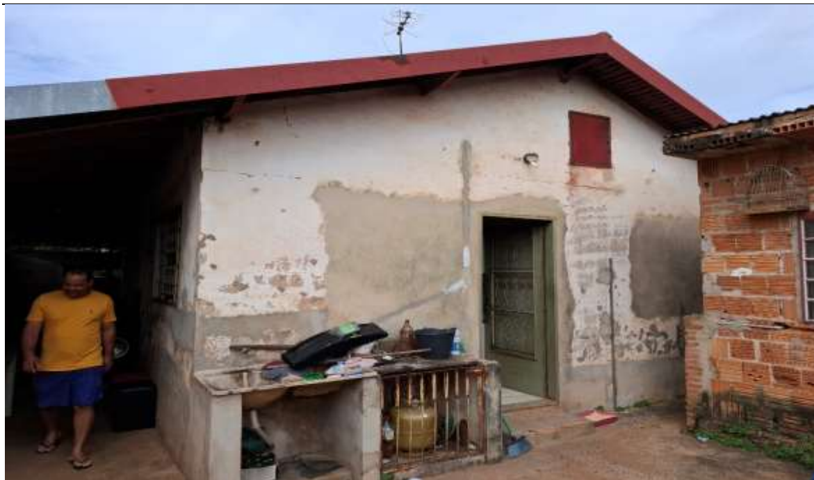
Foto Nº 08: Mostrando aspectos externos da Casa Principal.
