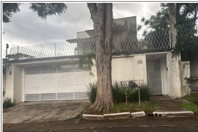
IMÓVEL - FACHADA - IMÓVEL
