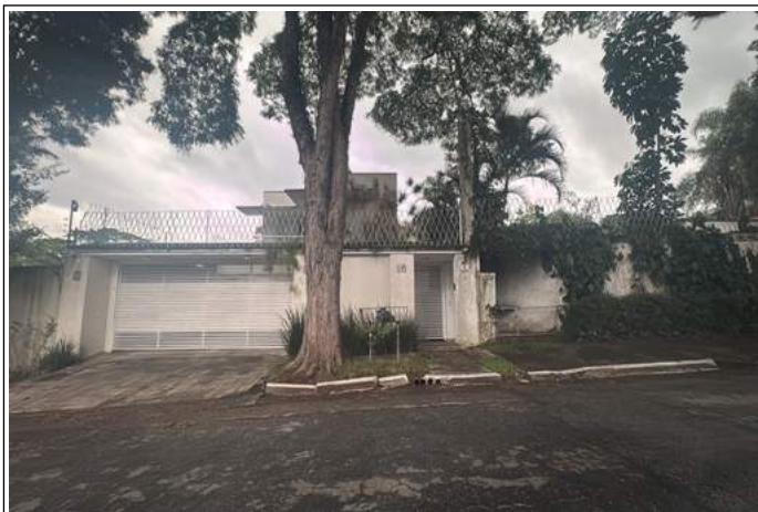
IMÓVEL - FACHADA - IMÓVEL
